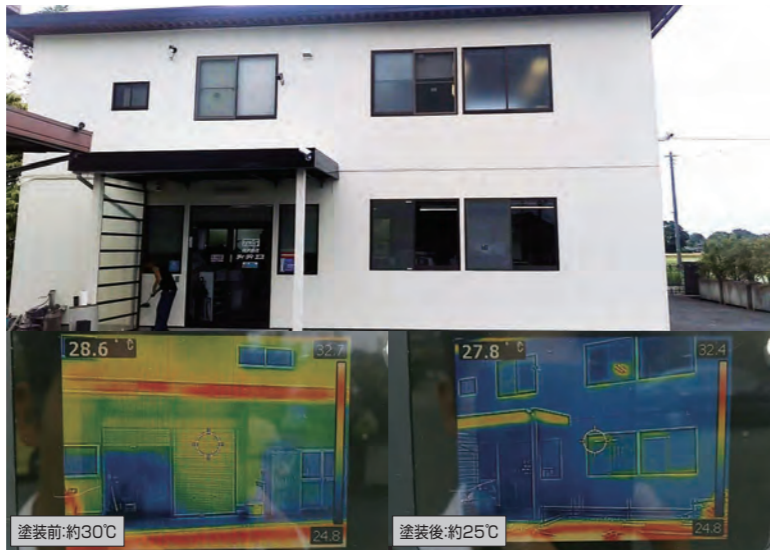
埼玉県羽生市社屋 HT001、HT002 埼玉県羽生市 2017年6月竣工
