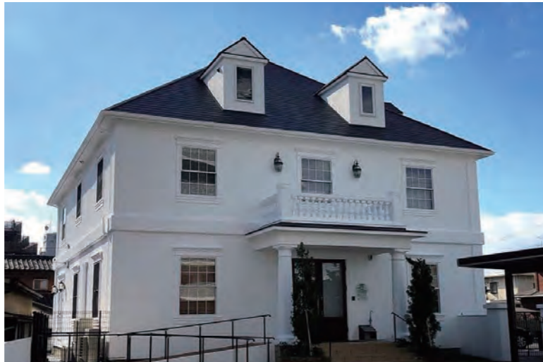
福岡県やまもとハートクリニック DT001、ピンチブラック 福岡県久留米市 2019年9月竣工
