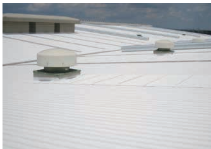
ハイドロサーモ施工事例（屋根）
